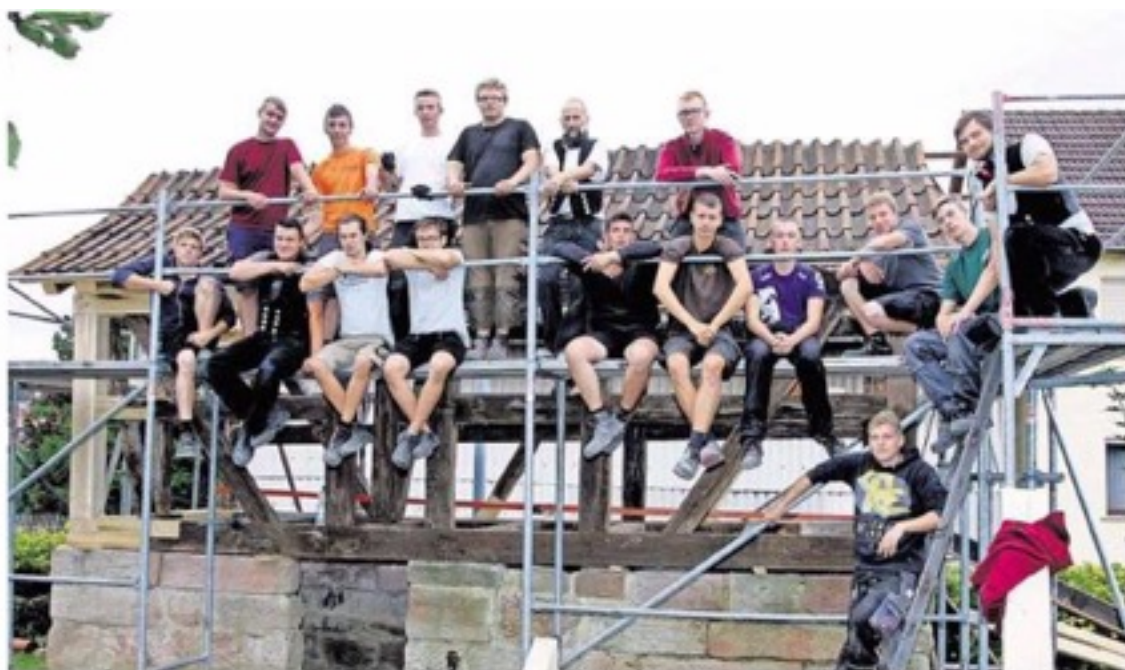
Zimmermeister Axel Möller (Bildmitte, stehend) mit den Lehrlingen vor dem Schweinekoben. Der Fambacher Handwerker ist Ausbilder im Aus- und Fortbildungszentrum des Baugewerbes Gotha und hat die angehenden Zimmerleute nach Breitungen gebracht. Sie hatten ganz offensichtlich ihren Spaß an Arbeit und Aufenthalt im Rußwurmschen Haus. Fotos (2): Jenoar-of-ir
